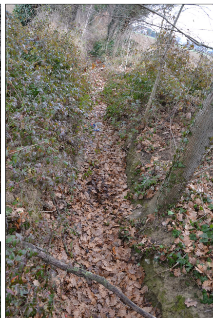
F4 Interno del canale di implivio
