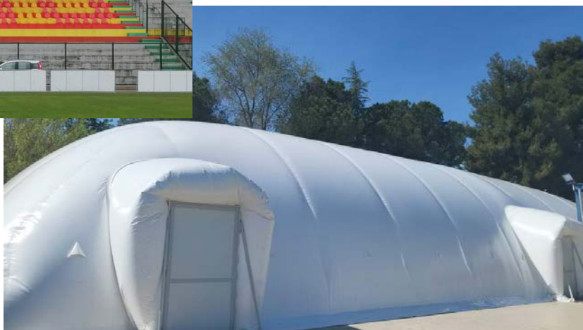
Nuova copertura Piscina comunale
